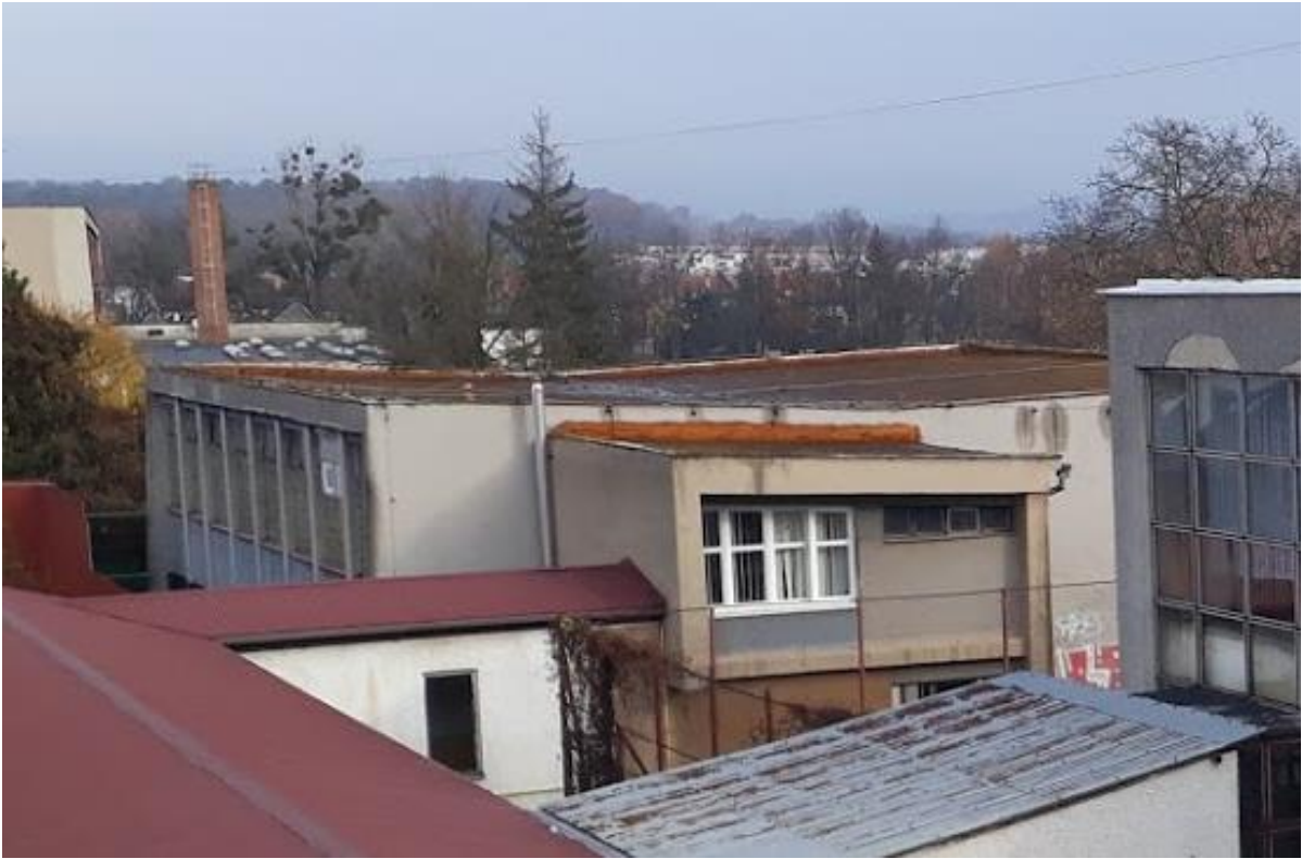
strecha telocvične S002
