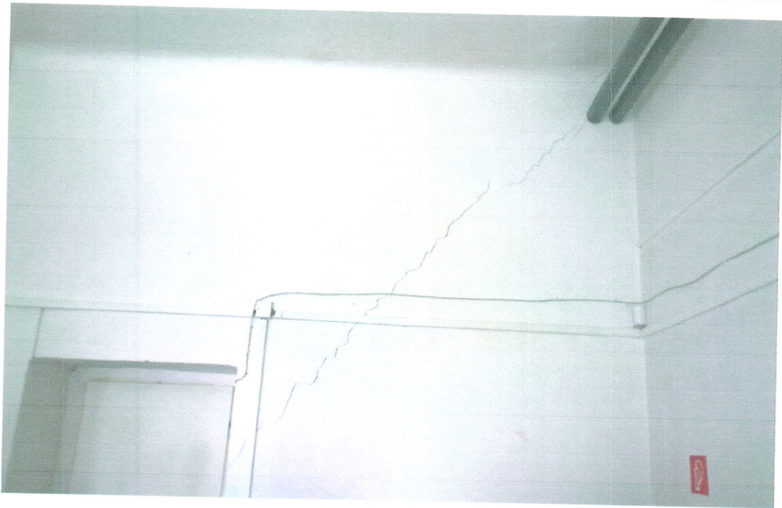
Pohľad na stredný nosný múr 2.poschodia
