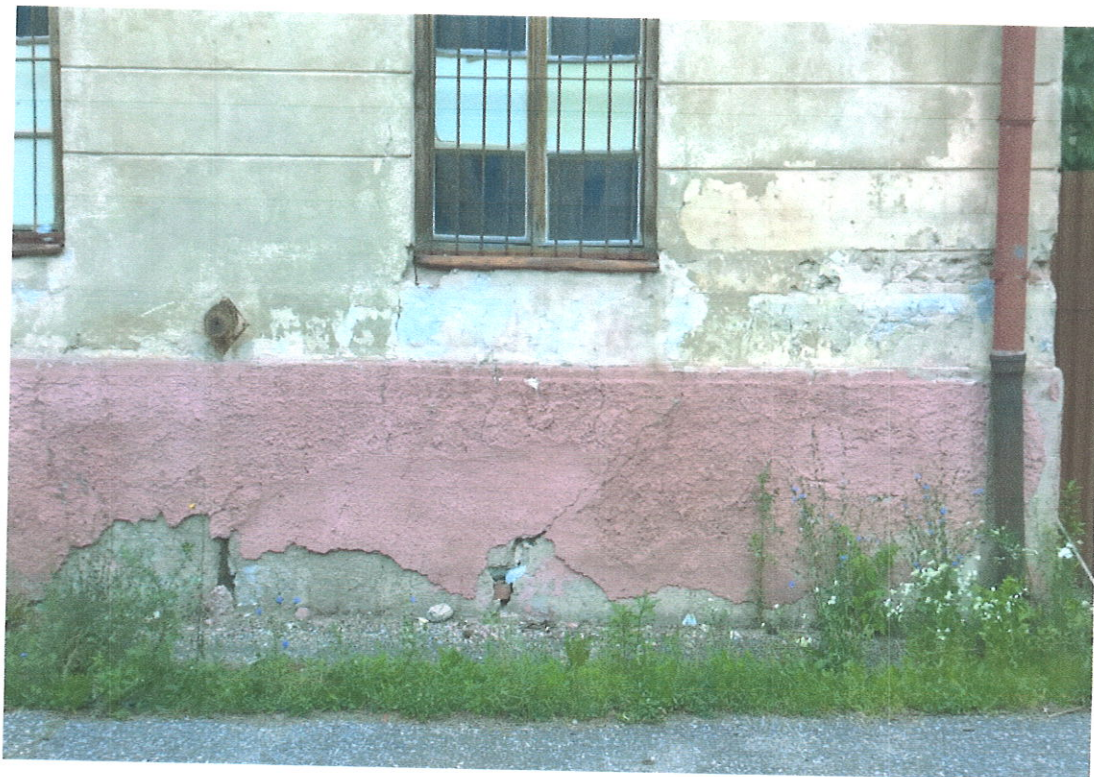
Pohľad na prízemie a sokel so základmi
