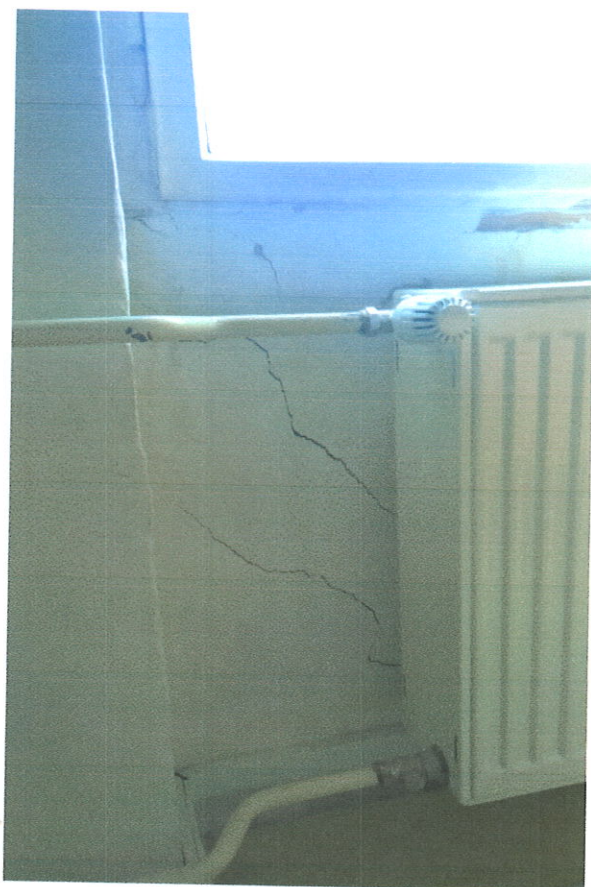
Pohľad na parapet južnej steny z interiéru
