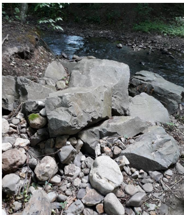
Vodozadržné opatrenie - spevnenie brehov potoka navezenými veľkými balvanmi
