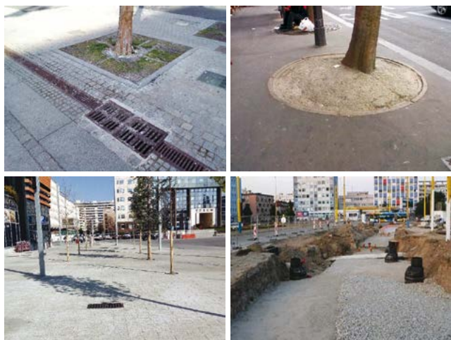
(foto: 58 – 61) Pečatenie urbánnych zón (Bratislava, Paríž, Lyón, Košice) sú typickým príkladom manažmentu dažďových vôd v našich mestách. Betónovanie veľkých plôch zemského povrchu a vynechávanie iba malého množstva pôdy pre zeleň. Používanie obrubníkov a kanálov bráni zeleni využívať dažďovú vodu a nedáva zmysel...
