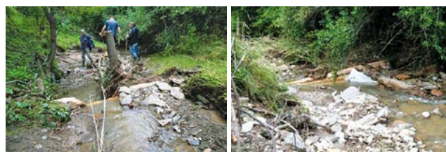
(foto: 89 – 90) Sedimentami úplne zaplnené hrádzky bez poškodenia...
