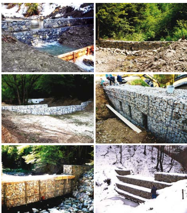
(foto: 26 – 31) Gabionové hrádzky (Krásno nad Kysucou, Vyšný Slavkov, Brehy)
