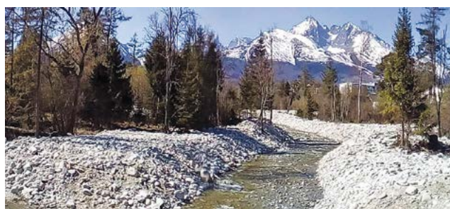
(foto: 78) Po povodniach v Tatrách došlo k regulácii Studeného potoka. Tieto riešenia prispievajú k vysušovaniu územia a zároveň pri ďalšej povodni takto upravené koryto bude zdrojom pre odnos kameňov nižšie po prúde.
