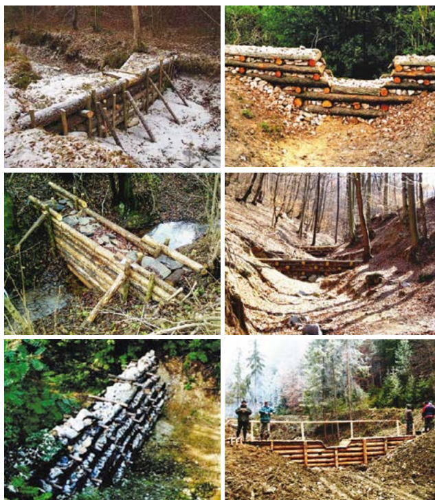
(foto: 20 – 25) Zrubové hrádzky (Olčava, Fričovce, Hlohovec, Matysová)
