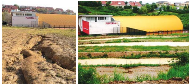
(foto: 106 – 107) Erózia na svahu na Košickom sídlisku KVP bola „preťatá“ vrstevnicovými hrádzkami na zadržanie dažďovej vody. Všetka dažďová voda ostáva na lokalite, a tým sa podporuje obnova ekosystému.
