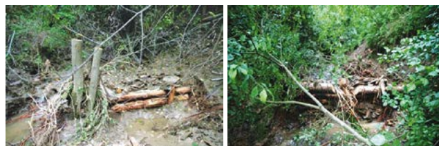
(foto: 87 – 88) V rokline sa okrem zanesenia hrádzok nakopilo množstvo konárov a biomasy, na ktorých sa zachytávali kamene a bahno.
