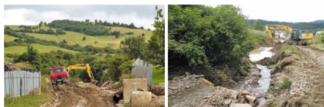
(foto: 85 – 86) Vejárovitá odtoková plocha cca 50 ha trvalo trávnych porastov. Údaje o výške zrážkového úhrnu nie sú známe. Údajne veľmi intenzívne pršalo cca 30 minút. Projekt sa začal realizovať 20. júna a do chvíle vzniknutej povodne zhotoviteľ projektu stihol zrealizovať 25 drevených prehrádzok o celkovom vodozadržnom objeme do 1000 m 3 . Podľa odhadov sa údolím rokliny prehnala povodňová vlna s objemom cca 15 000 m 3 . V pozadí vidno svahy trvalých trávnych porastov so sklonom svahov 15 – 25 %.
