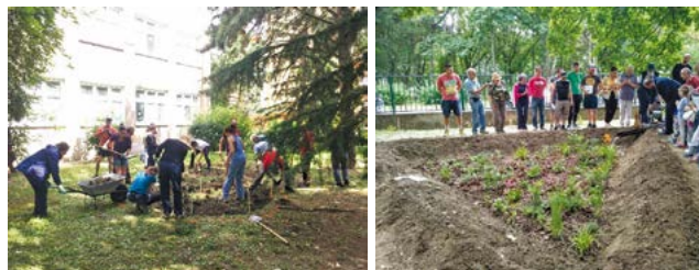
(foto: 149 – 150) Dobrovoľníci Letnej univerzity vody pri výstavbe dažďovej záhrady pri ZŠ Hroncová v Košiciach
