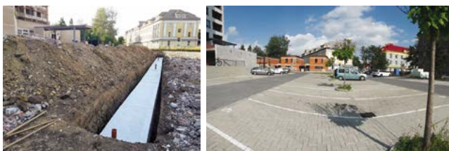
(foto: 151 – 152) Výstavba podzemného ekodrénu v Poprade znižuje odtok dažďovej vody z územia a zvyšuje zásoby podzemných vôd
