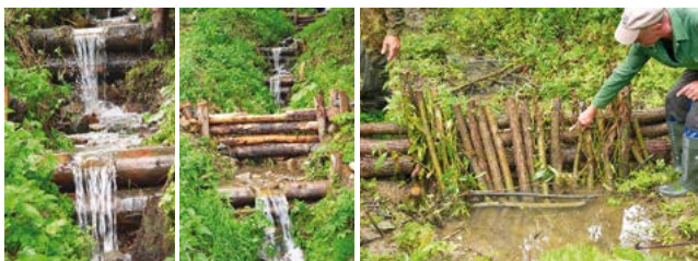
(foto: 122 – 124) Drobné vodozadržné opatrenia v poškodenej krajine sa dajú budovať všade, rôznej kvality i rôznej technológie. Základným princípom je spomaliť odtok dažďovej vody z územia a minimalizovať eróziu (Hrádzky v katastri obce Dúbrava).
