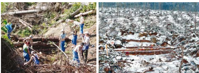
(foto: 102– 103) V území sa vybuďovalo viac ako 4000 hrádzok z odpadového dreva, ktoré zabraňujú odtoku dažďovej vody z územia
