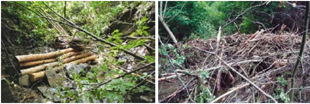
(foto: 93 – 94) Vytrhnutá a odhodená hrádzka na breh. Konáre navrstvené na ďalších hrádzkach utlmili stekanie kameňov...
