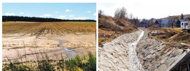
(foto: 74 – 76) Orba po spádnici a regulovanie potokov je najintenzívnejší spôsob vysušovania územia. Odnos pôdy, erózia a následné budovanie „tobogánov“ na odvádzanie povodňových vôd dolným susedom na „hlavu“ je prejavom starej kultúry pre vodu.
