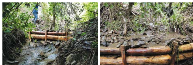
(foto: 91 – 92) Sedimentami a konármi naplnené hrádzky, ktoré zachytili ďalšie sedimenty, miestami aj cca 0,5 m vyššie, ako je vrch hrádzky.
