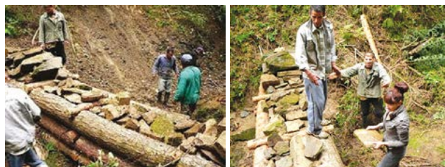
(foto: 120 – 121) Budovanie hrádzok v Jarovniciach. Práca na budovaní vodozádržných opatrení bola zmysluplná a prinášala aj potešenie ich aktívom s občasnou návštevou ľudí z miestnej komunity.
