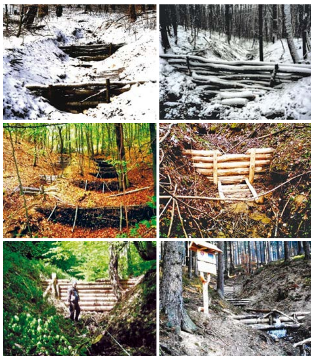
(foto: 5 – 10) Pre klasické drevené hrádzky odporúčame používať drevo odkôrnené (Malá Lodina, Kojatice, Kružľová, Zázrivá, Oravská Lesná)
