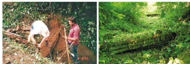
(foto: 98 – 99) Prvé hrádzky v suchej eróznej rýhe v roku 1996. Prvé pramienky vody začali vyvieriť od roku 1998. Od vtedy roklinou stále tečú vlasočné vody aj v najsuchšom období.
