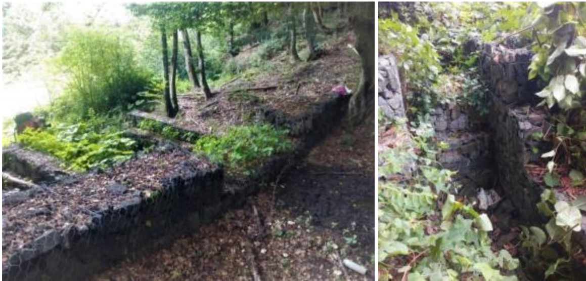
Postavené gabióny v Čermel'skom údolí a nad Ťahanovcami zrealizované 2005, Foto z r. 2020
