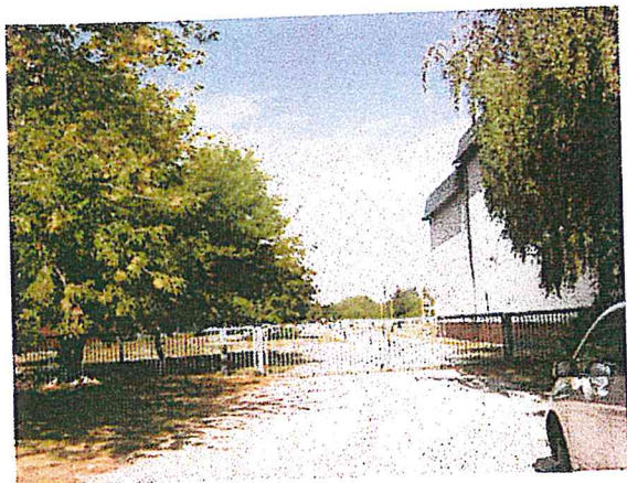
Vstup do areálu školy
