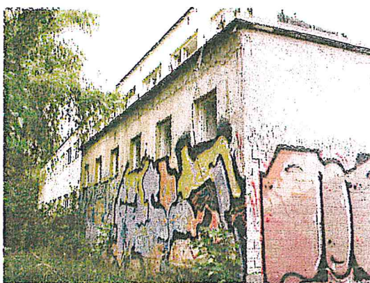
budova „B“ na parc. č. 115
