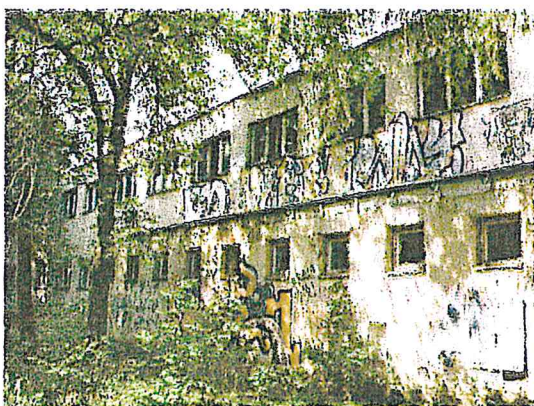
budova „A“ na parc. č. 116
