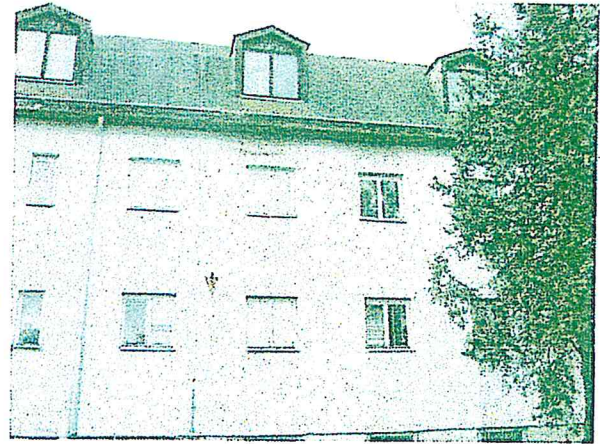
Pohľad severný od ulice Okružná
