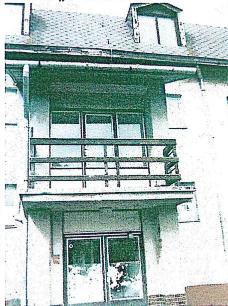
Pohľad východný vstup
