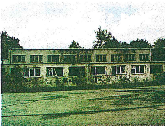
telocvična na parc. č. 112
