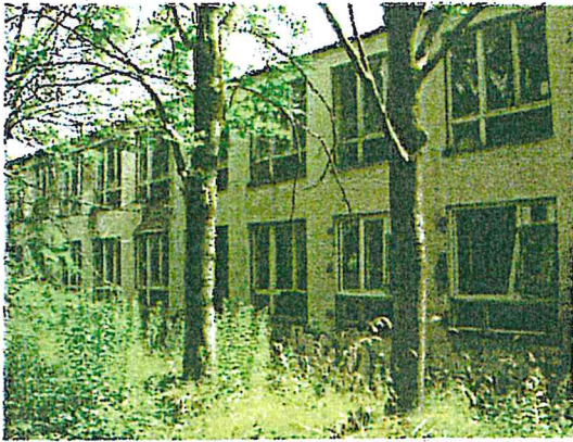
admin. budova na parc. č. 118
