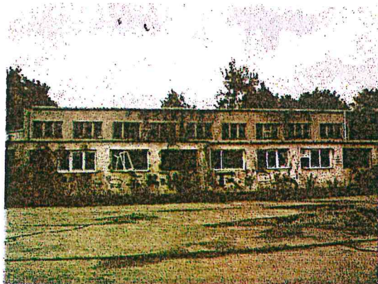
telocvična na parc. č. 112
