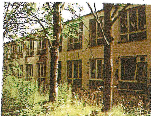
admin. budova na parc č. 118
