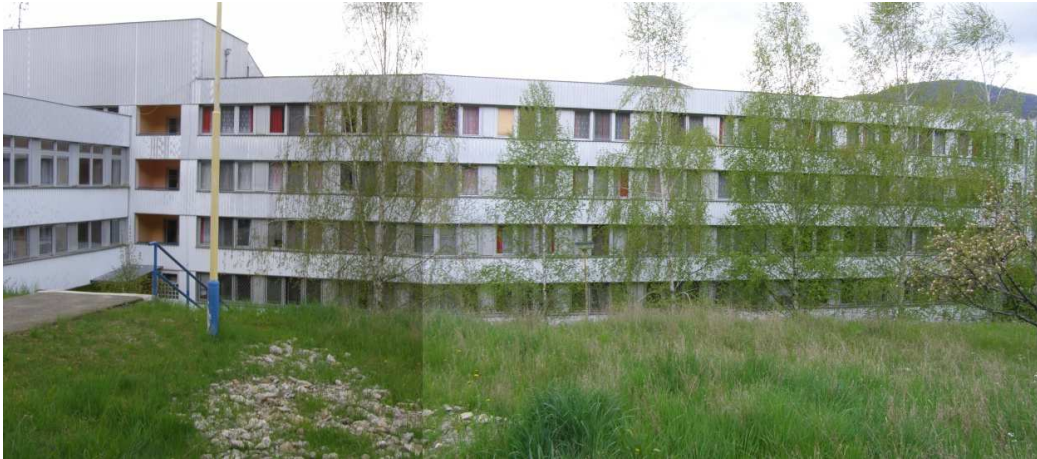
Obr. 6 Pohľad na južnú štítovú stenu a južnú časť východného priečelia, od juhovýchodu
