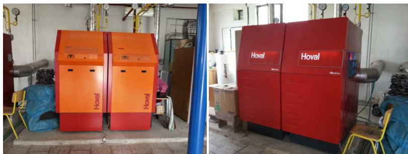
Obr. 4 Plynová kotolňa
